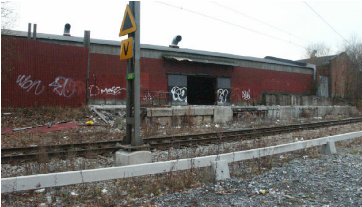
Fig. 02. Albano vid Värtajärnvägen. Magasin som ska rivas för ny bebyggelse. Förslag på detaljplaner föreligger. Den nya bebyggelsen ska anpassas till NSP:s intentioner att förstärka natur- och parkmiljöerna.
